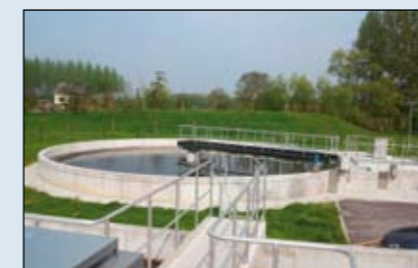
Pont raclé calrificateur
