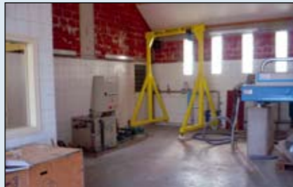
Bâtiment traitement des boues
