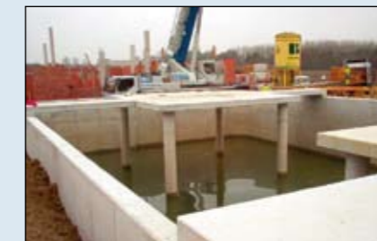
Traitement biologique, en construction
